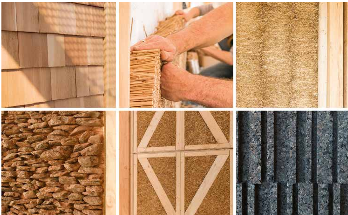
Die Stützen bilden eine hölzerne Tragstruktur, die Ausfachungen bestehen aus Rohstoffen sowie aus Materialien mit geringer Umweltbelastung. The supports form a wooden load-bearing structure, the infills are made of raw materials as well as materials with a low environmental impact.
